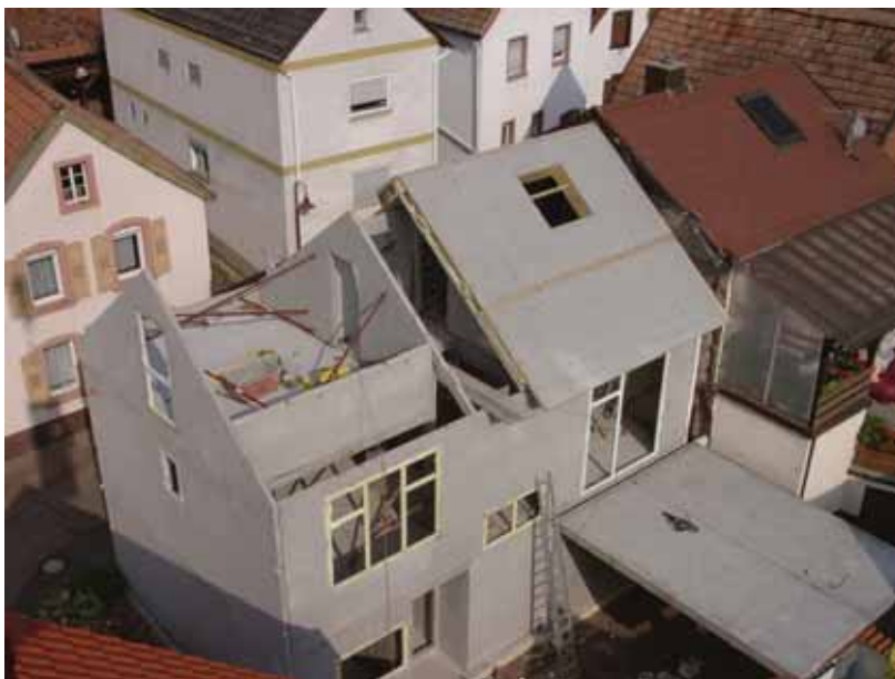
The house in Annweiler nearing completion - image courtesy of Lösch Systembauteile GmbH + Co.
